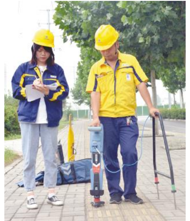
使用仪器检测埋地燃气管网
