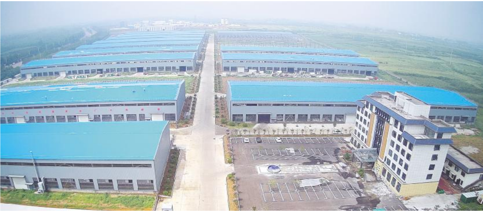
航拍汝合再生项目厂区
