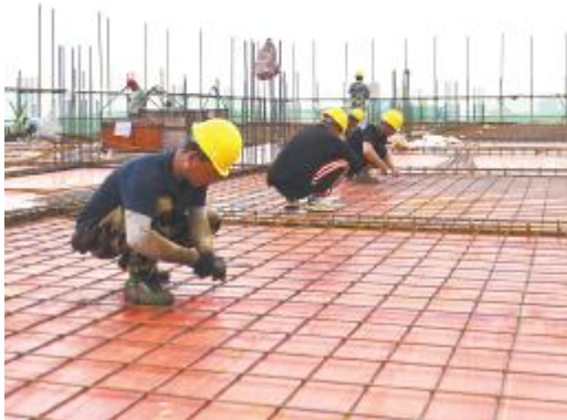
工人正在进行顶板钢筋捆扎
