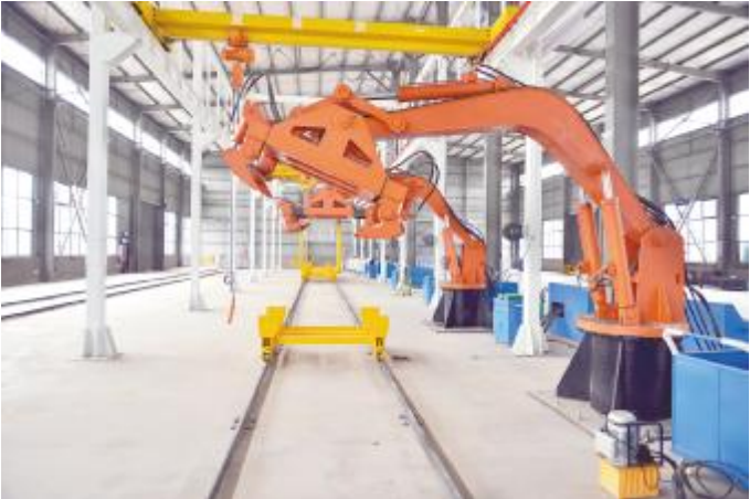
汝合再生全自动化汽车拆解设备安装完毕
