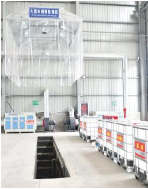
油污环保处理设施建设完成
