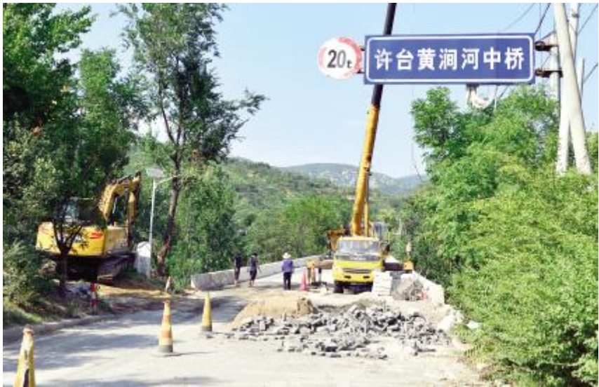
许台黄涧河中桥水毁工程施工现场
