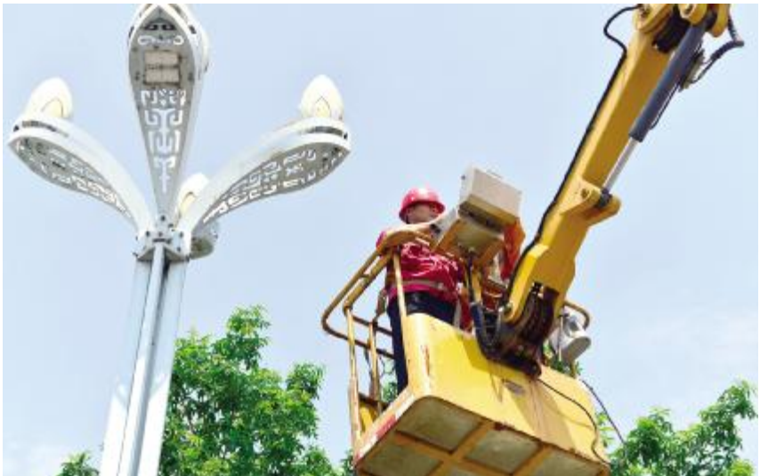
路灯维修工正在作业
