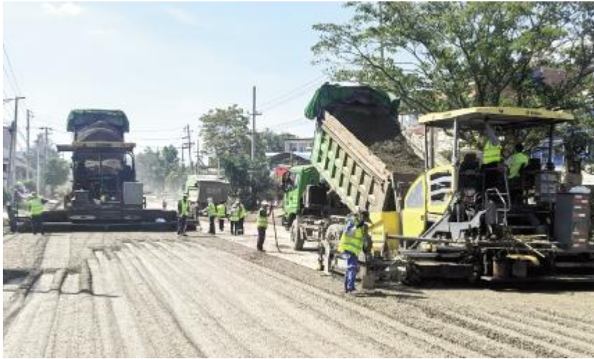
烈日下省道水稳层铺设现场
