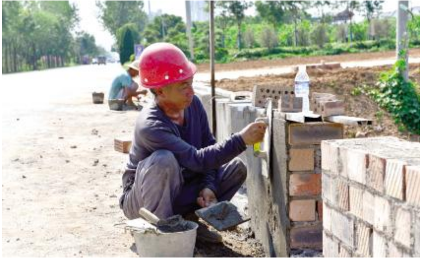
候饭线于庄路段工人正在垒砌路边安全护栏
