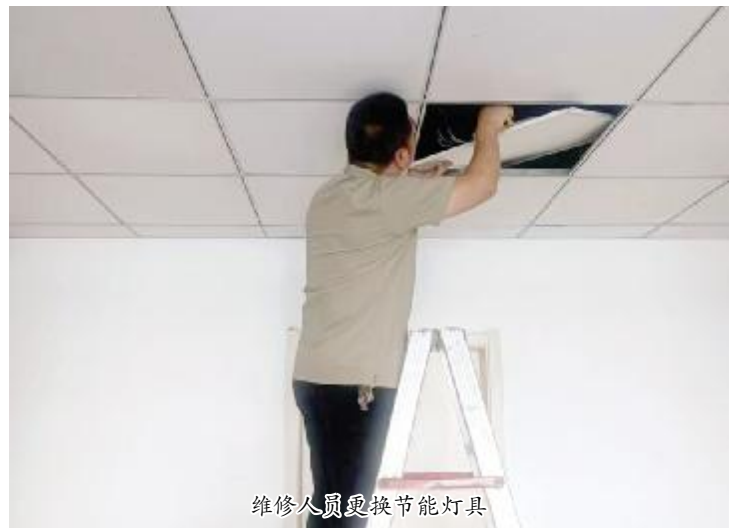
维修人员更换节能灯具
