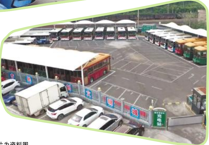
建设新能源充电站投入使用
