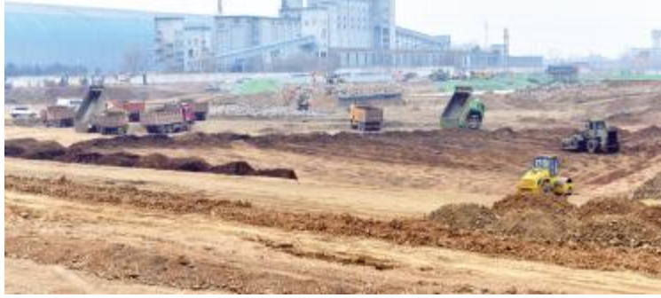
天瑞煤化工项目施工忙
