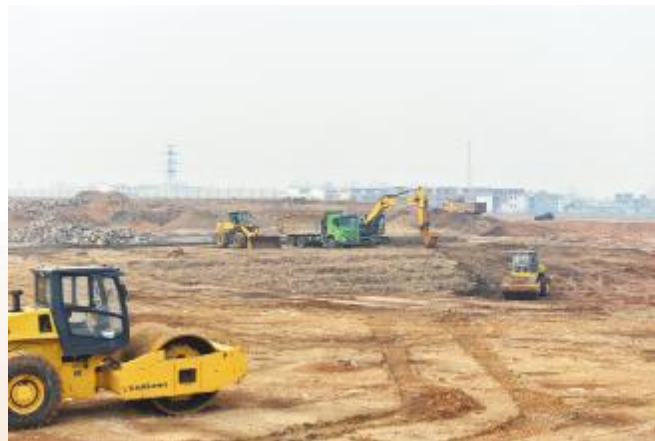
施工现场一片繁忙
