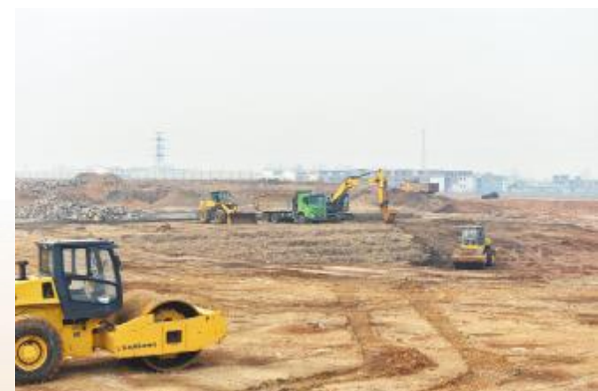
施工现场一片繁忙
