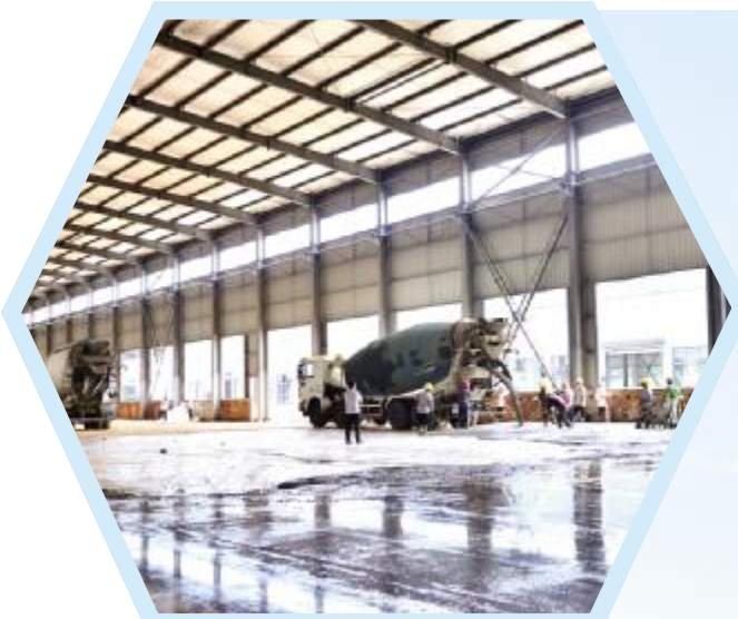
工人、机械配合作业
