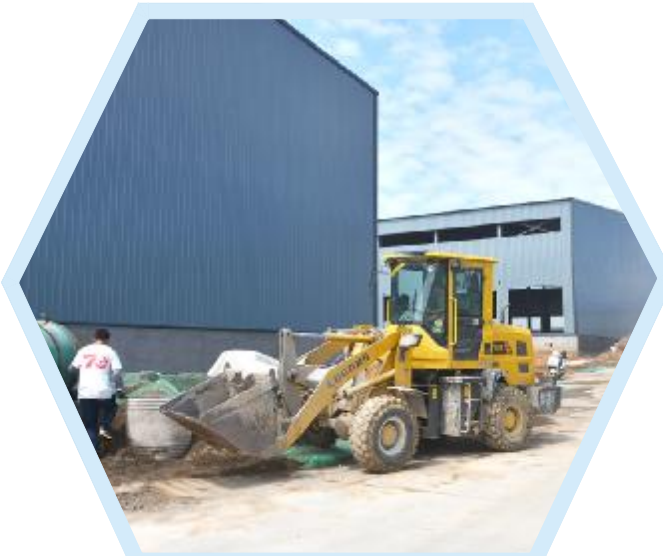
施工现场一片繁忙
