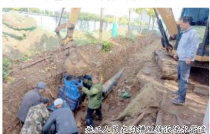
施工人员在沟槽里铺设供水管道
