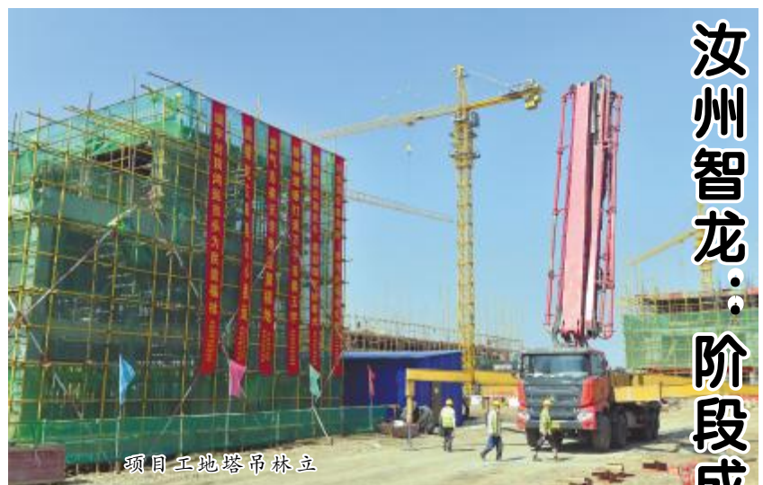
汝州智龙：阶段成果喜封顶 项目建设再提速
