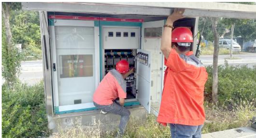
国庆前夕，市城市路灯管理所实施城市路灯精细化管理，共排查路灯安全隐患12处、维修路灯61盏、整理架空线路3处、检修路灯专变设施10余台，确保国庆期间汝州市照明设施正常运行，为全市人民营造明亮的夜间出行环境。图为9月26日，市路灯管理所工作人员在市区主干道朝阳路上检修、维护城市照明设施。 宋乐义 张少丹 摄
