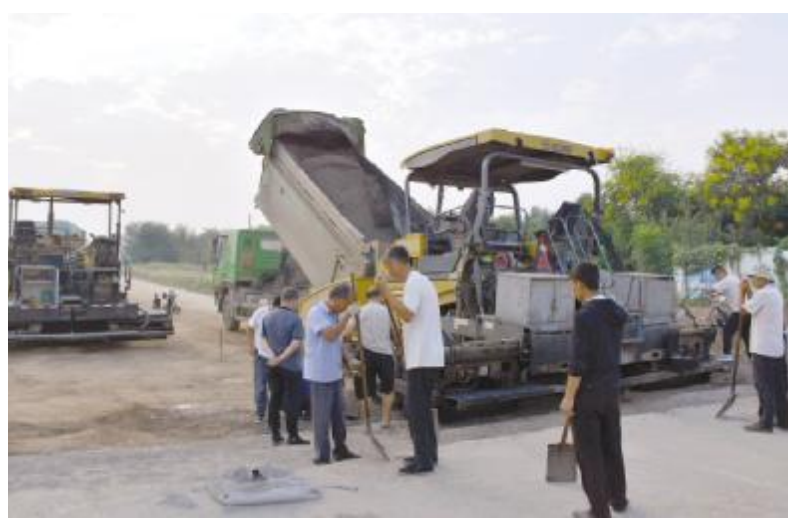
近日，记者在丹阳路东延道路工程项目施工现场看到，道路清表、主车道路床整形、给水管道、电力和照明预埋管已经完成铺设，水泥土基础层铺设完毕，工人们正在铺设水稳层，预计9月30日前完成主路面沥青铺设，达到通车条件。 陈晶晶 摄
