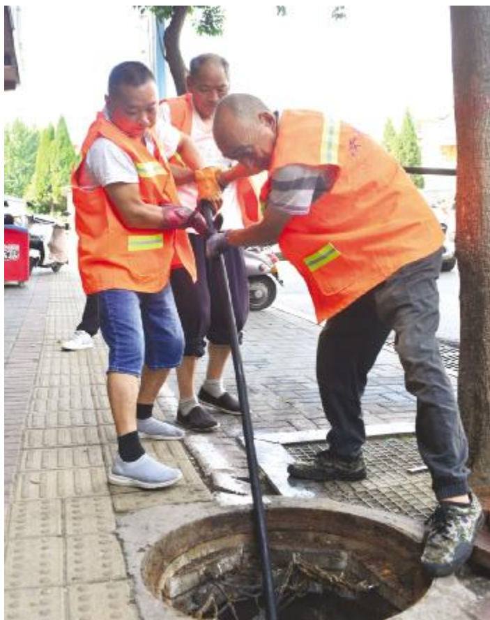
市政养护工人协力合作疏通堵塞的污水管道
