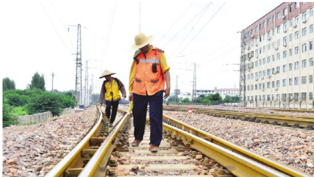
铁路工务段工作人员在烈日下巡检铁轨安全
