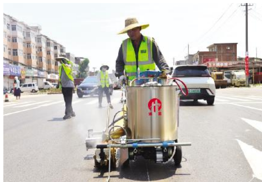
公路工作人员进行道路标示标线铺设作业
