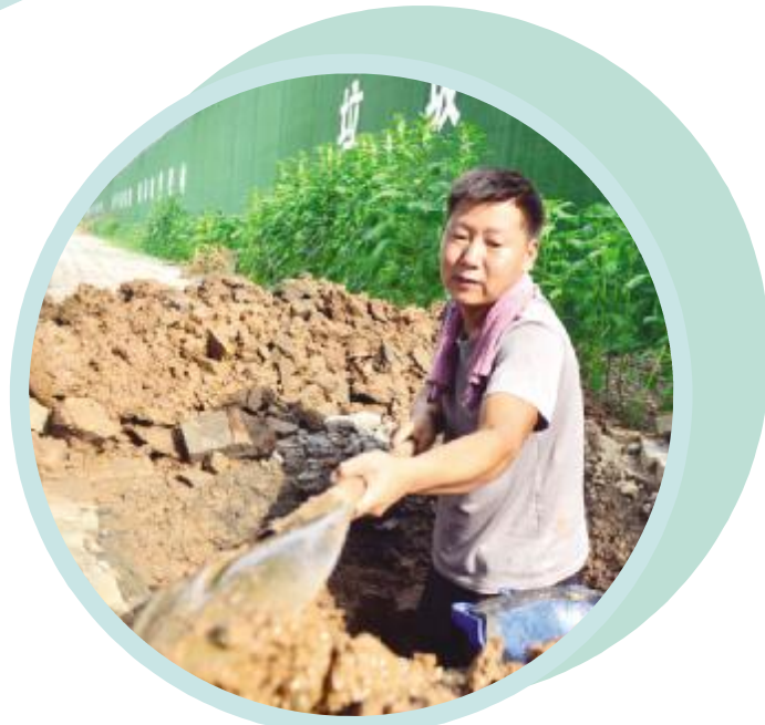
自来水管网维修工开挖 抢修漏水管
