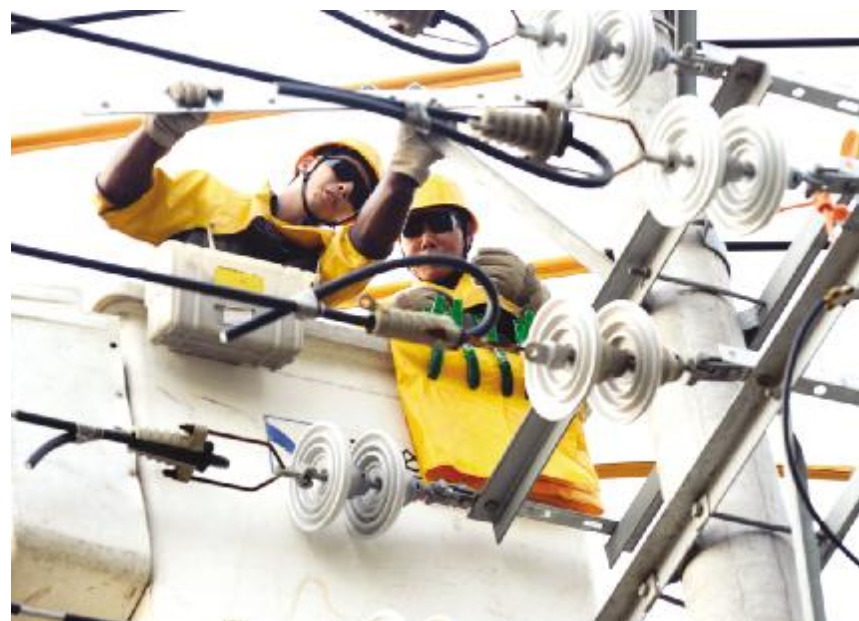
高温下,电力工人抢修线路
