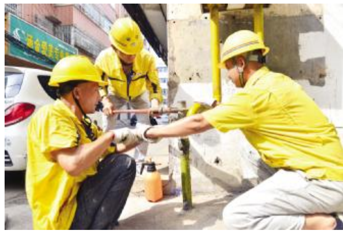
天然气维修工合力抢修漏气管道
