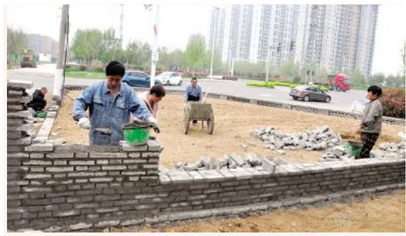
紫云路街道铁炉马村西路口处的一片空地上,曾经杂草丛生、垃圾遍地,严重影响村容村貌。整治“十乱”行动开展以来,该村两委研究决定,将空地清扫干净后,建设一个小型绿地景观,提高人居环境质量。图为4月12日,工人们加紧建设。 李浩然 于俊鸽 摄
