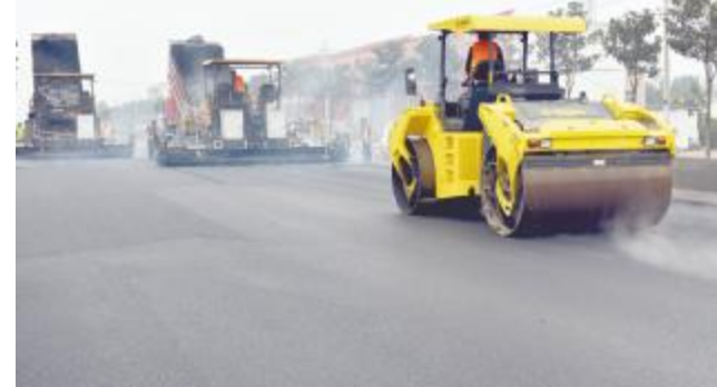
国道铺设施工
