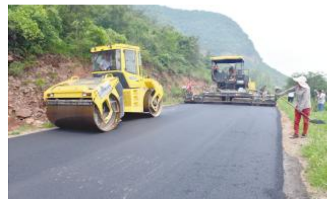
乡村道路铺设施工
