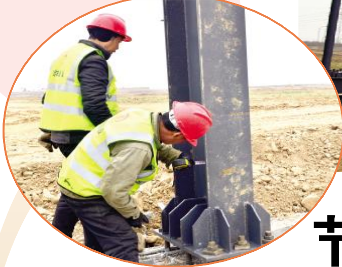
▼在河南汝合再生资源有限公司项目工地，施工工人正在测量钢架结构的水平和厚度
