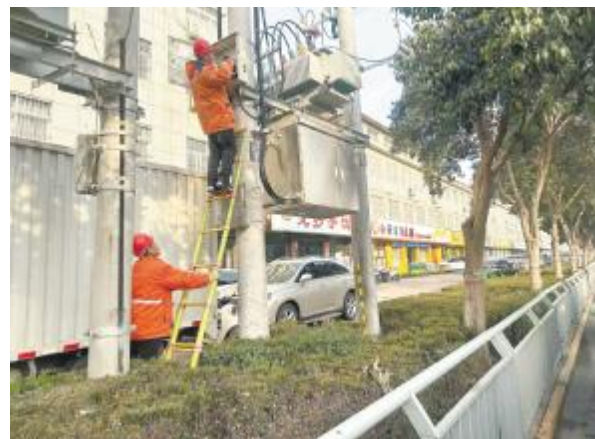
连日来，市住建局路灯所对市区城市照明设施全面检修维护。此次检修，共更换变压器高、低压熔断器熔管及熔丝13套，接地线、引线100米，避雷器保养20套，确保春节期间市区各类城市照明设施安全正常运行。 宋乐义 张少丹 摄
