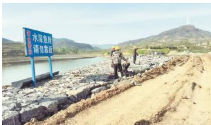
水库除险加固施工现场
