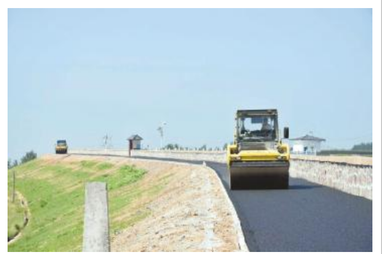
水库环线道路铺设
