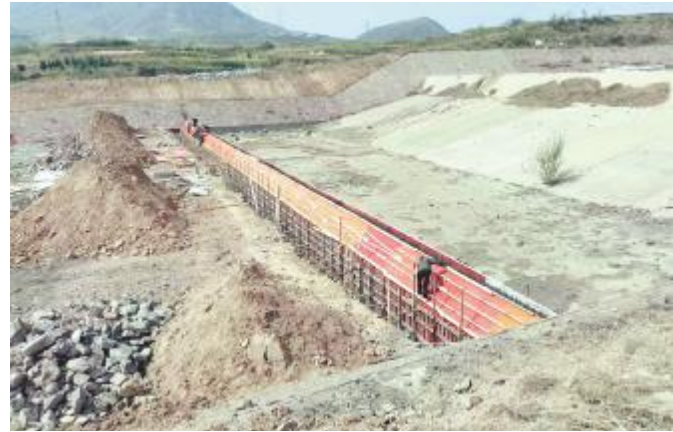
水库溢洪道加固改造
