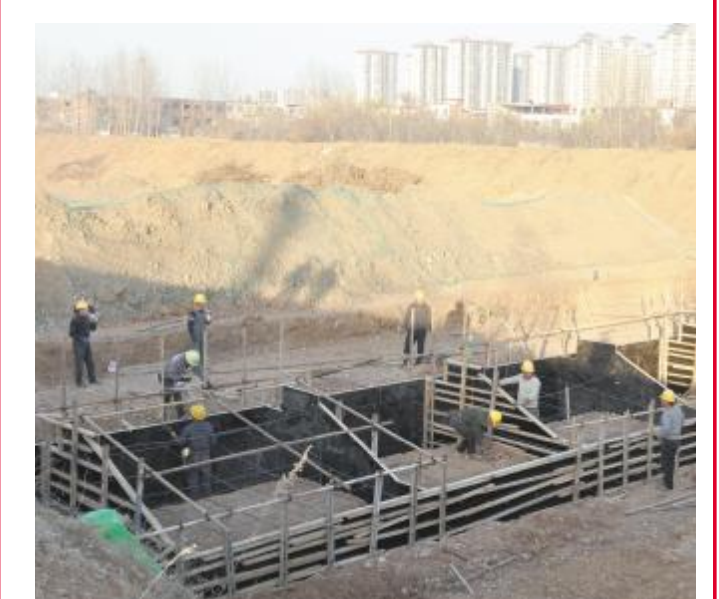
12月7日，记者在洗耳河河道治理工程现场看到，工人正在10号溢流堰加紧施工。预计2024年元旦前后，8、9、10号溢流堰将建成并完成试水。张沛沛 摄
