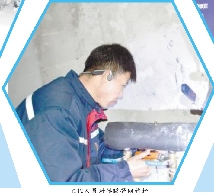
工作人员对供暖管网维护
