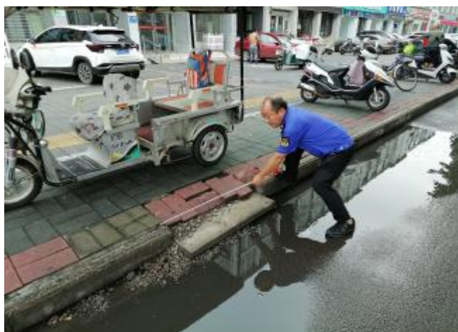
测量脱落的侧平石大小
