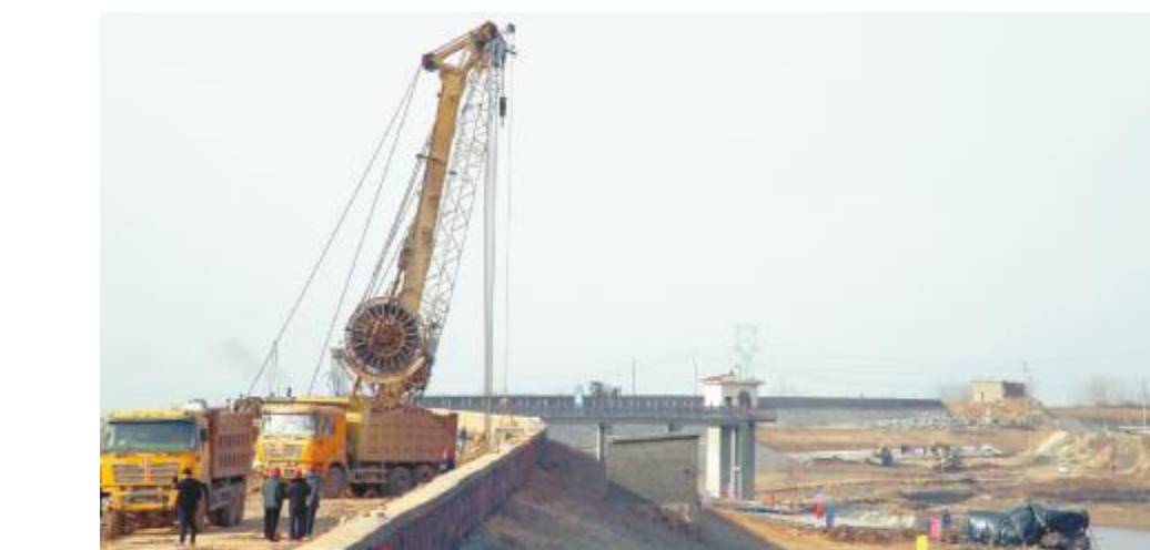
夏店水库位于市区西北部,在淮河流域北汝河支流荆河上,控制流域面积37平方公里,是一座以防洪为主,兼顾灌溉、水产养殖等综合利用的小型水库。在省有关部门的大力支持下,夏店水库除险加固工程列入2023年南水北调中线左岸风险水库项目。图为日前夏店水库除险加固工程现场的施工场景。李浩然 刘晓廷 摄
