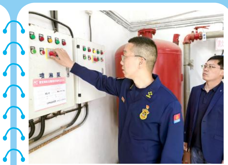
5月8日，市消防救援大队相关负责人带队到市妇幼保健院，实地督导检查消防知识应急会、消防栓使用、灭火器使用等消防安全生产工作，要求严格履行检查巡查、隐患排查、宣传教育、定期演练和应急处置等职责，及时消除火灾隐患。李浩然 范鸽子 摄
