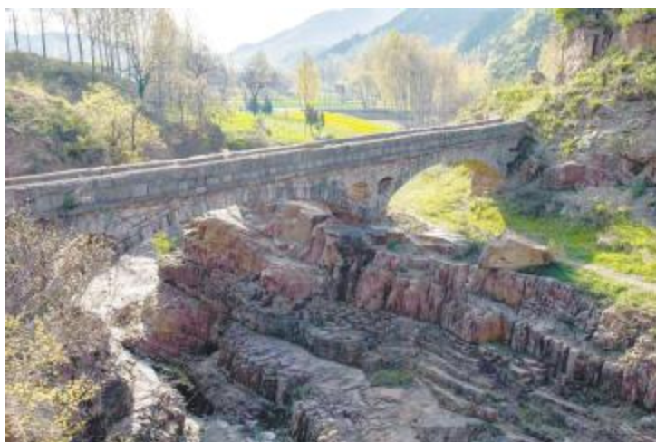
溪桥底下有清流
