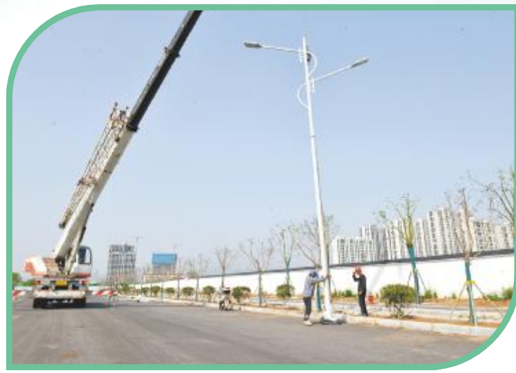
金庚医院新址南北路，工作人员正在安装路灯
