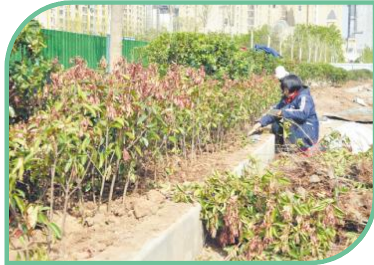
建材路东延施工现场，工人正在栽种绿植
