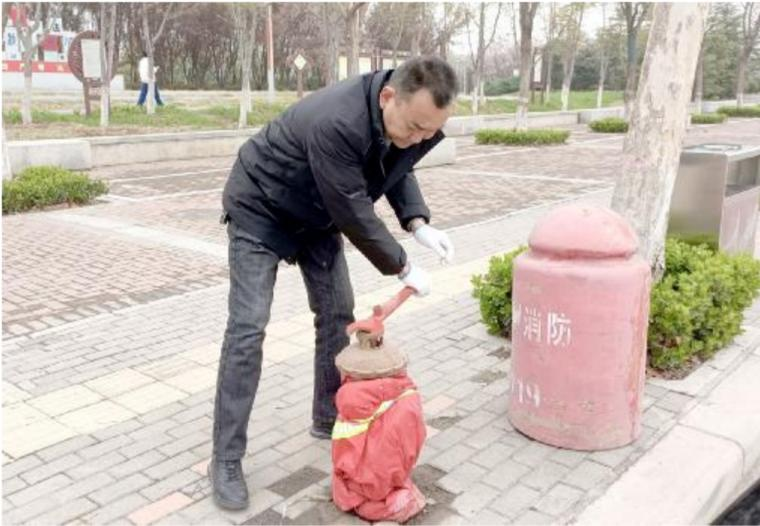
3月21日，市自来水公司组织工作人员排查城区市政消防栓。检查人员按路段逐一排查，重点检查消防栓阀门、接口是否完好，消防栓的零部件是否有损坏，消防栓水压是否正常等情况。同时建立排查台账详细登记，及时维修更换，消除消防安全隐患，筑牢消防安全防线。 梁杨子 雷文娟 摄
