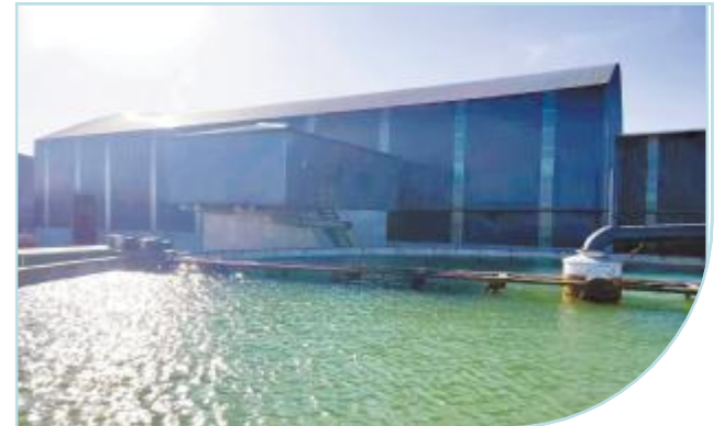
汝州市丰鑫年产120万吨精煤洗选项目
