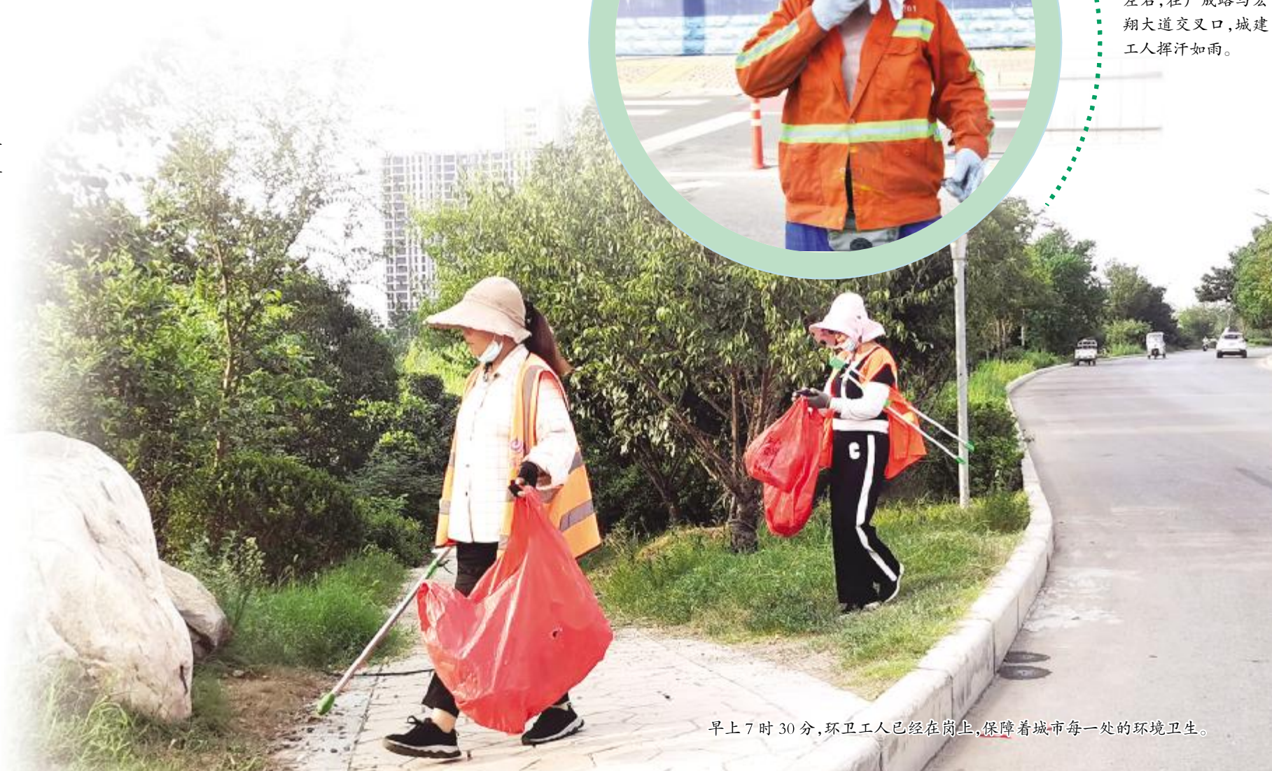
上午10时30分,在市标东南角,工作人员正顶着高温安装道路导向牌。
