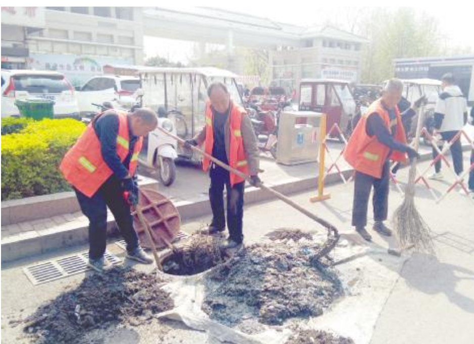
4月11日上午,在广成路西段,3名市政工人正在对一处排水管网清淤施工,确保夏季汛期道路排水管网雨水畅通无阻。据市政有限公司相关负责人介绍,汝州城区共有市政排水管网148公里,目前,朝阳路、广成路、丹阳路、中大街、城垣路、西环路等28条主次干道排水管网和城区排水末端泄洪渠清淤作业正在有序推进中,预计到4月下旬,全市148公里市政排水管网清淤任务可全面完成。
