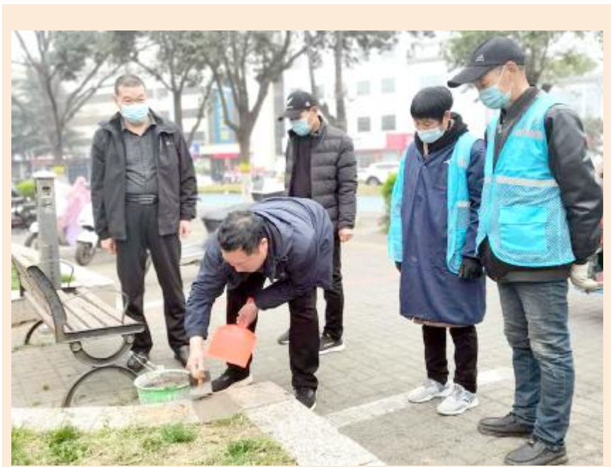
3月25日，市园林中心在工人文化宫游园组织基础设施维修培训活动，40余名一线人员参加。培训以修复破损道牙为主，设备维修组人员以“演示+讲解”模式实地操作讲解道牙修补技术要领。梁杨子 焦小丽 摄
