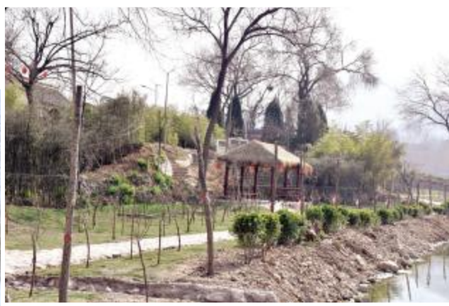
河畔一侧连廊新景
