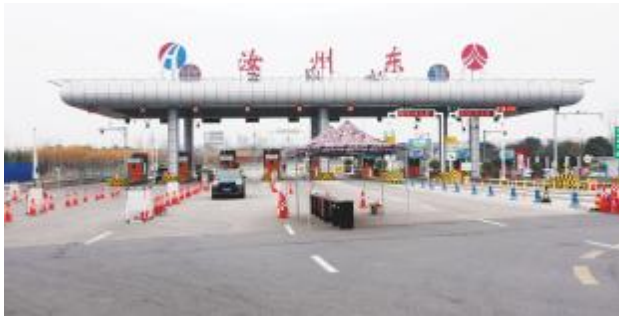
高速路口恢复正常通行秩序 张亚萍 摄
