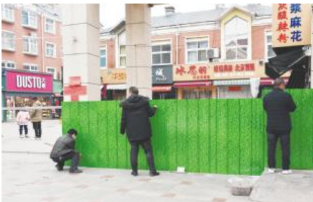
步行街拆除隔离围挡 张亚萍 摄
