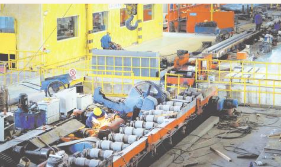
工人们正在加班加点检修设备
