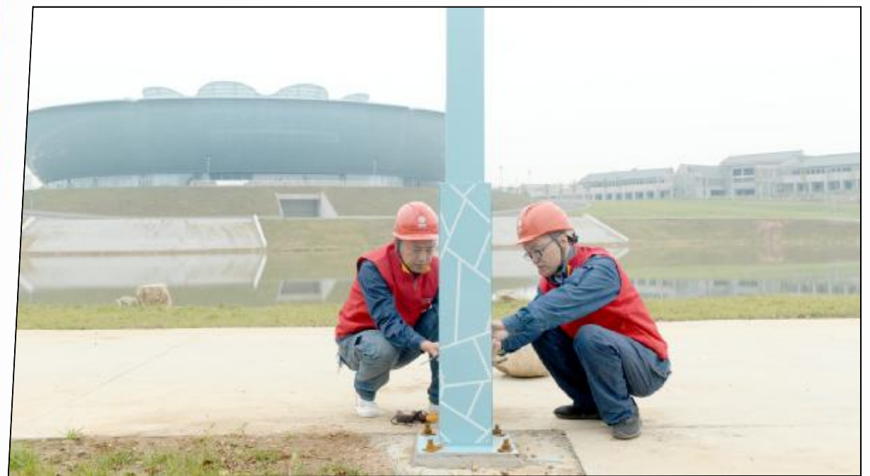
市供电公司员工加班加点检修线路
