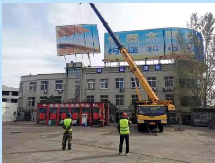
近日，凤穴路街道联合城市管理执法局及专业施工单位，对辖区建筑楼顶大型户外广告牌依法进行拆除，全力消除安全隐患，确保辖区群众“头顶上的安全”。 张亚萍 摄
