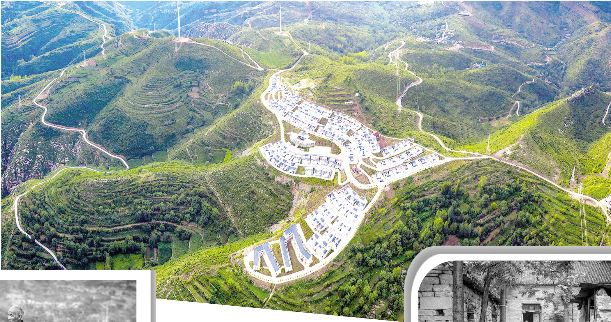
世外桃源般的下焦新村全貌
