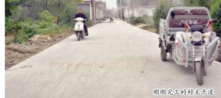
刚刚完工的村主干道
