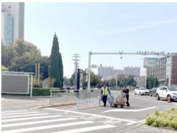
9月22日，工人们在市区朝阳路段，施划地面交通标识线，规范交通秩序。
