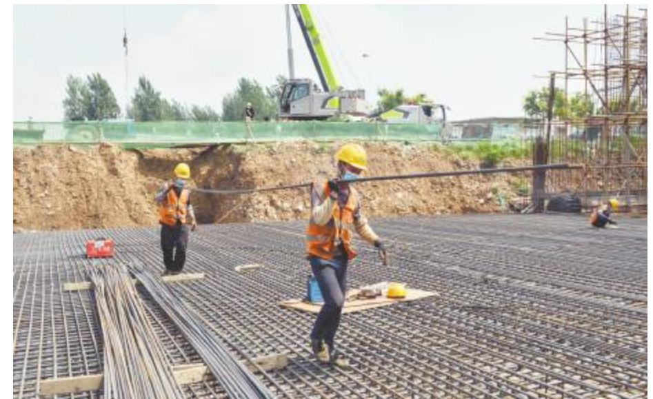
市产业集聚区污水处理厂项目加紧施工
