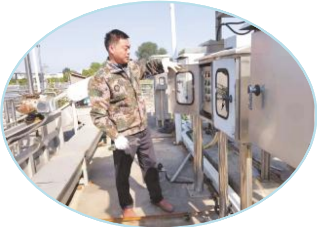
赵建强检查污水处理设备
