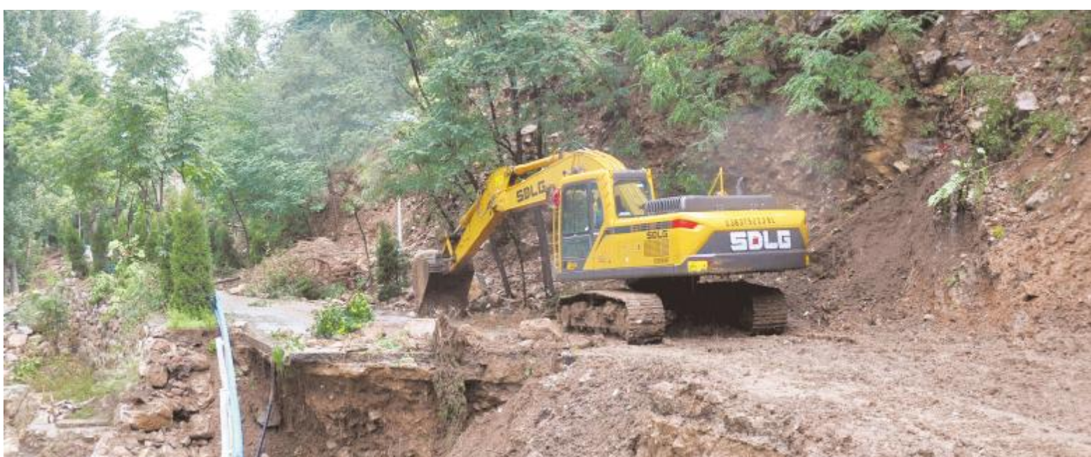
清理大峪至班庄公路塌方
