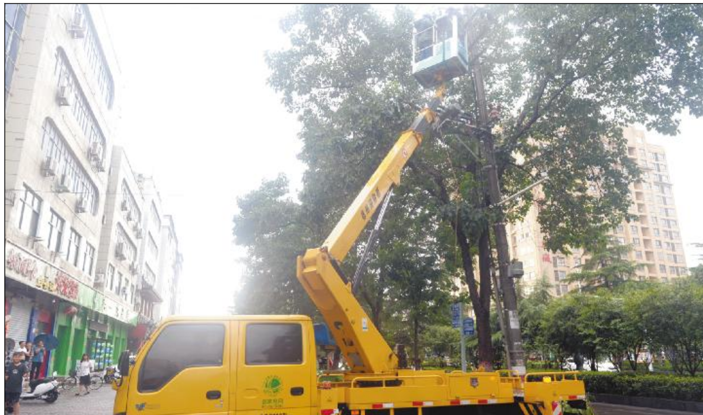
7月20日,电业工人积极抢修电路,保障市民供电。
