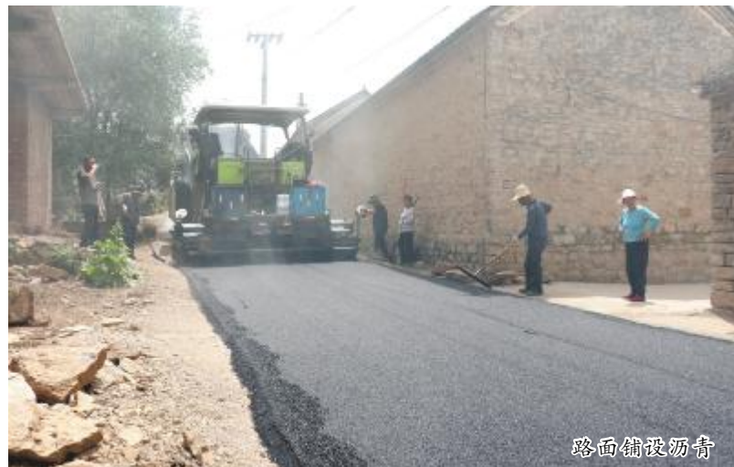
路面铺设沥青
