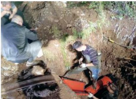
4月30日，市区东环路和望城路交叉口一处供水主管道断裂。市自来水公司安排维修人员迅速到达现场全力展开抢修，经过近4个小时的努力，供水管道于当晚9时30分修复成功，居民恢复正常供水。 刚鑫雨 雷文娟 摄
