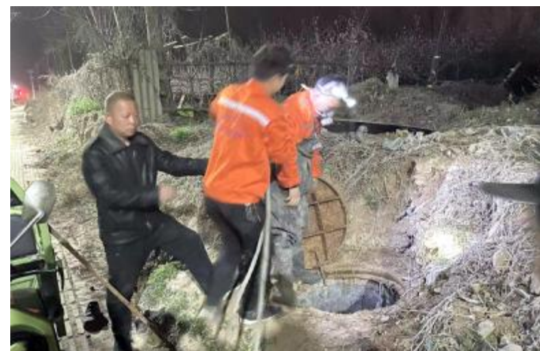
3月16日晚，滨河路运维单位组织人员下井并对南刘庄污水口堵塞管道进行疏通。
