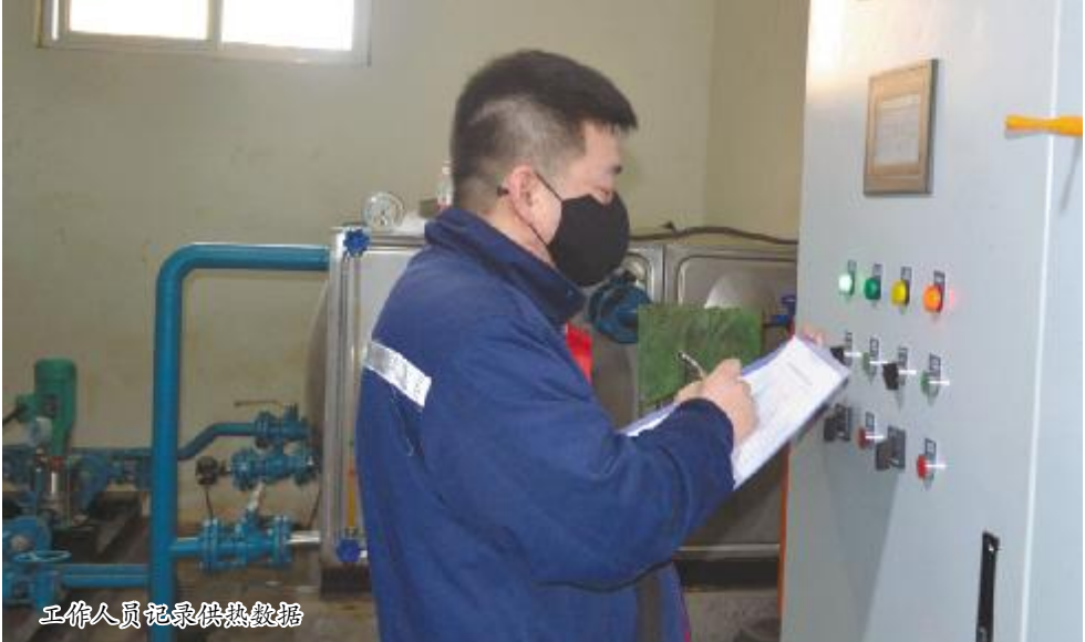
工作人员记录供热数据
