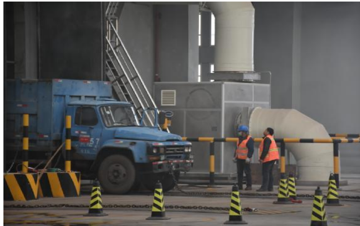
近日,在汝州市静脉产业园厂区内,垃圾车在垃圾卸料平台卸垃圾。据了解,汝州市静脉产业园固体废物综合处理项目设计总规模为日处理垃圾1300吨,一期建设规模为日处理垃圾800吨,预计每年处理生活垃圾25.55万吨,餐厨垃圾1.83万吨,干化污泥1.83万吨,年发电量9110万kWh,年上网电量7288万kWh,年可节约3.2万吨标准煤,真正实现了垃圾的“变废为宝,转废为能”,有效改善生态环境,实现社会效益、生态效益、环境效益的结合统一。 张亚萍 摄
