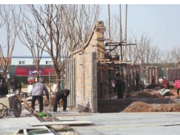
乐华城一期建设工地
