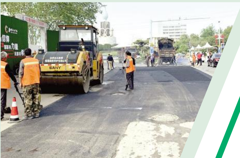
开展城市体检，修复市标南侧道路
